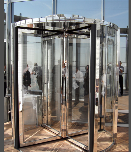
'Tornadobestendige' tourniquetdeuren op de 124e en 148e verdieping van de Burj Khalifa in Dubai
